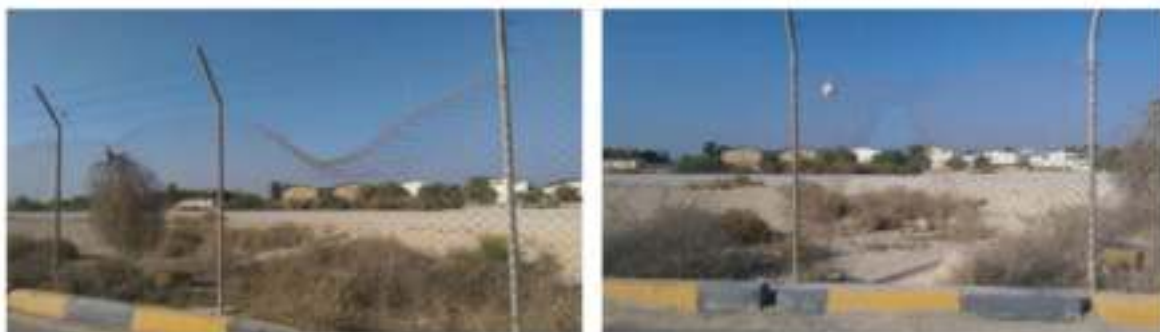
نمونه ای از ضعف حصار کشی سنتی و معمولی
